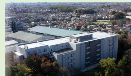
東京第一物流センター
