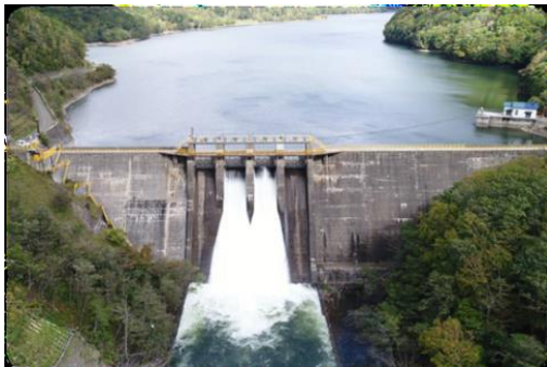
幌満川第3発電所ダム
