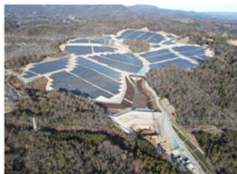
茨城県北茨城市磯原町特高発電所
