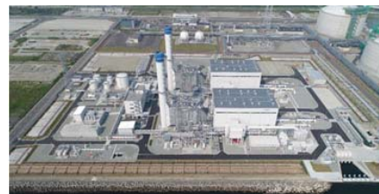
福島天然ガス発電所
