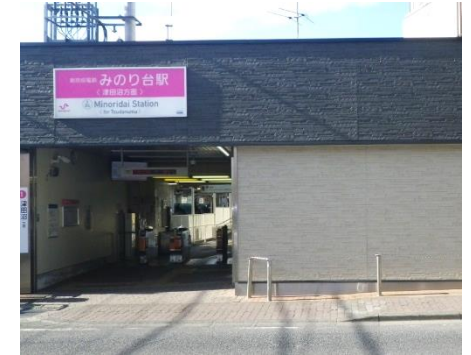
みのり台駅耐震補強
