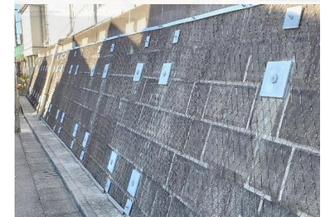
松戸新田駅土留め壁補強
