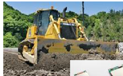
GNSSシステムブルドーザ
