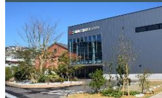
航空エンジン新工場稼働
