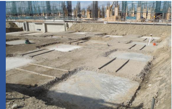
湿式浅層改良工法の施工状況
