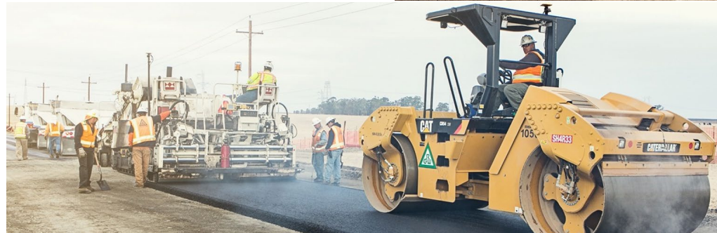
道路工事現場におけるICT活用事例
