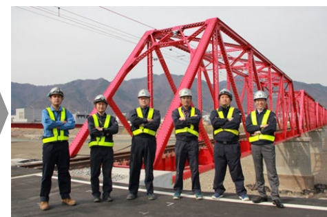
【千曲川橋梁 復旧後】
