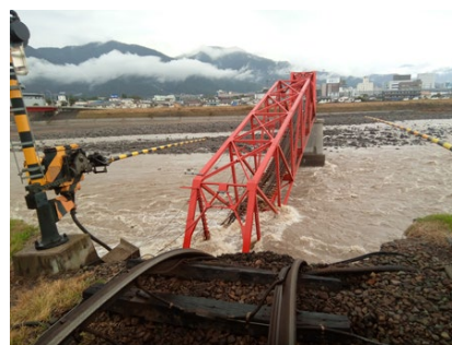
【千曲川橋梁 復旧前】
