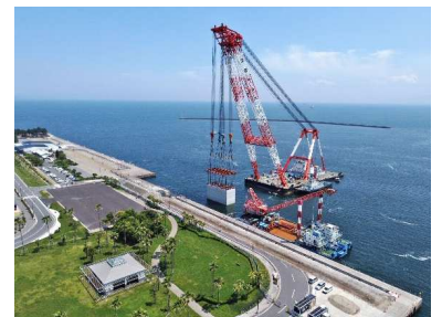
令和元年度鹿児島港(中央港区)岸壁築造工事(鹿児島県)
