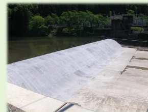
摩耗、洗堀対策用 高強度繊維補強コンクリートパネル メンテナンス事業
