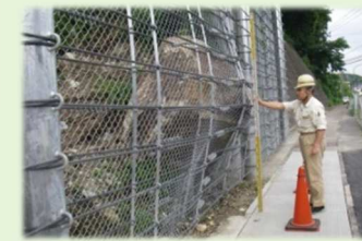
落石・崩壊土砂対策 ループフェンス
