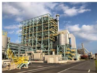
市原バイオマス発電所
