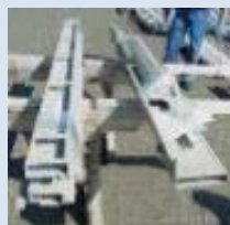
セット搬入：現場で取付ける部材を出荷時にセットで梱包のうえ搬入
