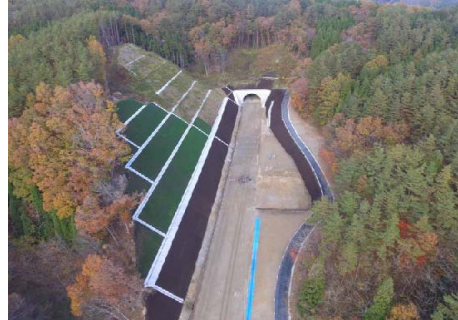
国道45号近内地区道路工事
