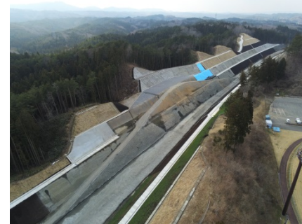
国道45号野田地区道路改良工事
