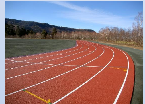
御嶽パノラマグラウンド改修工事
