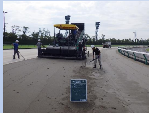
中京競馬場ダートコース路盤補修工事
