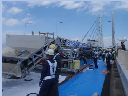
縦取り機を活用したSFRC舗装工事 (東京外環自動車道)
