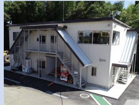
江戸崎合材工場(茨城県稲敷市)
