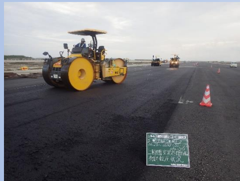
那覇空港滑走路増設舗装工事
