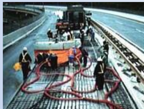
高速道路での床版のコンクリート除去作業
