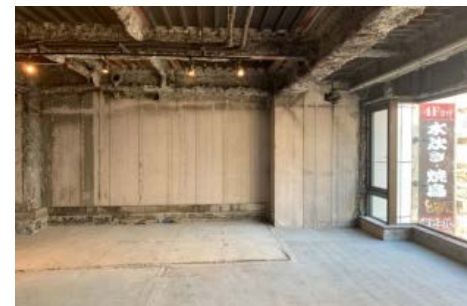
解体原状回復工事
