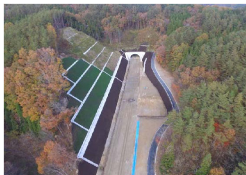
国道45号近内地区道路工事
