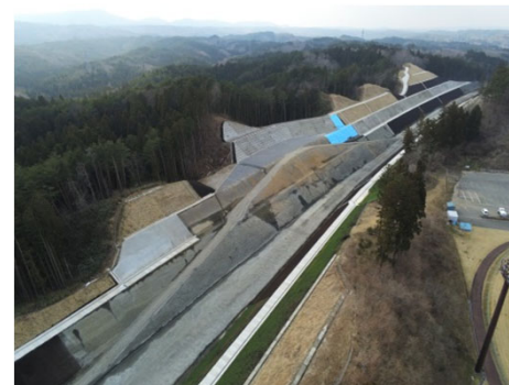
国道45号野田地区道路改良工事
