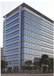
A-18 晴海センタービル
