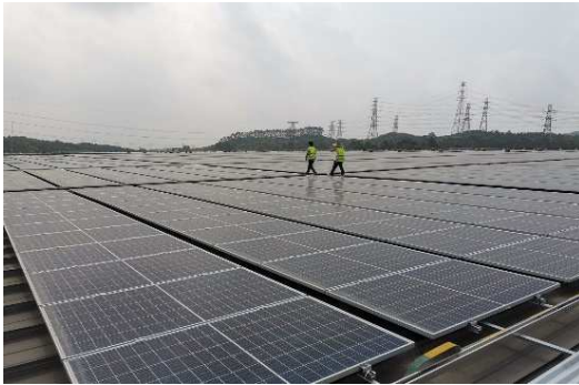
工場屋根にソーラーパネルを設置 (広州・タイ)
