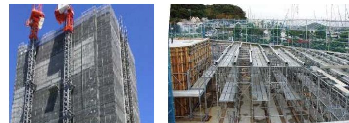
進化する足場「アルバトロス」
