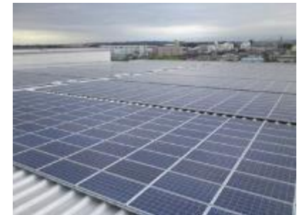
鴻巣研究所屋上に太陽光発電を設置
