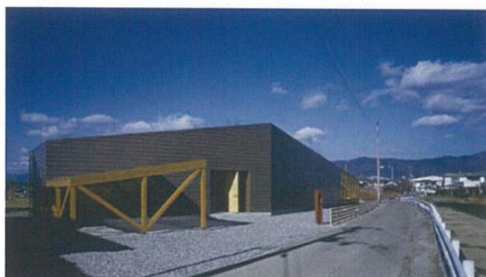
「鴨島の家 kamojima 1」(徳島県吉野川市) 設計:堀部直子 施工:ASJ光と水の街スタジオ 写真:市川かおり
