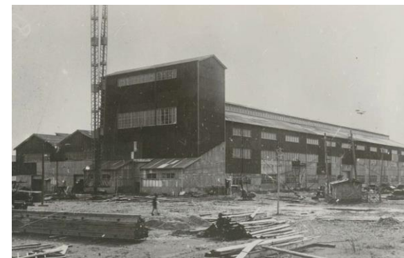
建設中の播磨工場
