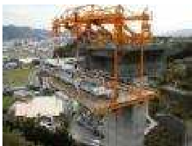
新東名高速道路橋脚工事
