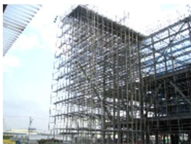
大規模倉庫屋根成形工事
