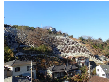
東興ジオテック 令和2年度急傾斜地崩壊対策工事（公共） その1
