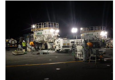
東興ジオテック 令和2年度 東京国際空港C滑走路他 地盤改良工事
