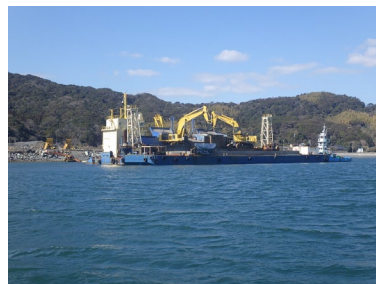
青木マリーン 福山港箕沖地区護岸（-10m）築造工事 （その2）
