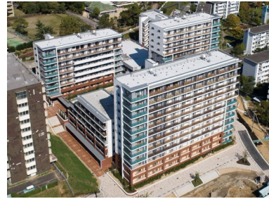
青木あすなろ建設 29-新千里東町団地先工区建設工事
