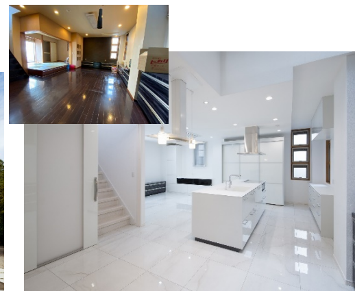
高松テクノサービス 大阪 住宅 内部改修工事
