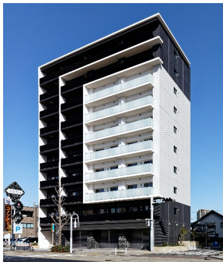
高松建設 御器所・Hマンション 新築工事
