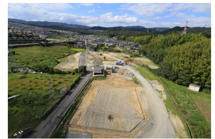
島田組 令和2年度埋蔵文化財調査業務委託 （実施場所：高槻市）
