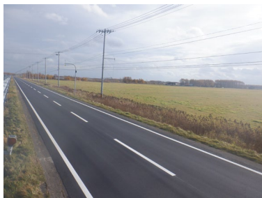
あすなろ道路 中標津標茶線舗装（構造改良）工事 中標津出張所工区
