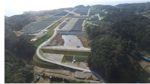
青木あすなろ建設 勝浦市興津太陽光発電所建設工事 (土木工事)
