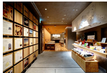
エムズ 『わたす日本橋』 日本橋三井タワー2階入居工事
