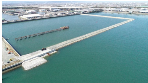
みらい建設工業 弥富ふ頭第1貯木場北側護岸 整備工事(その1)
