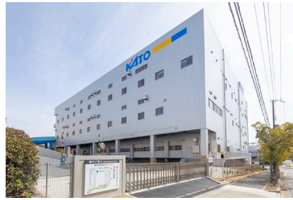
青木あすなろ建設 加藤産業(株)西近畿支社 神姫支店新築工事
