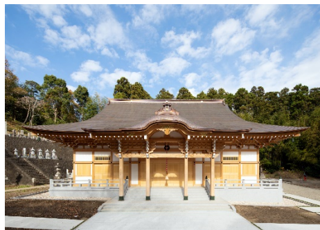
金剛組 大本山鷲山寺本堂新築工事
