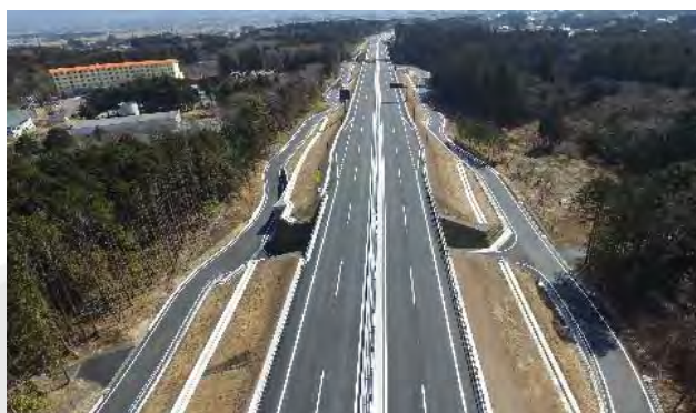
138号BP水土野南地区舗装工事
