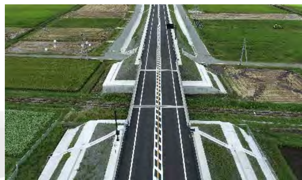
災害復旧熊本57号赤水地区舗装工事
