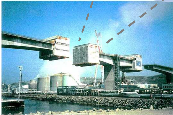
桁橋の張出架設工法のイメージ
