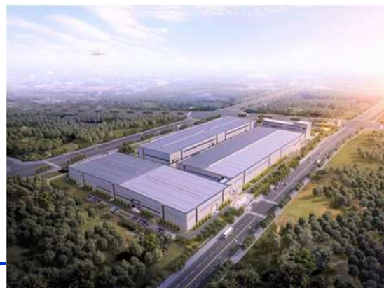
上海中煉 第二工場 重慶分公司 (2020年12月より稼働)
