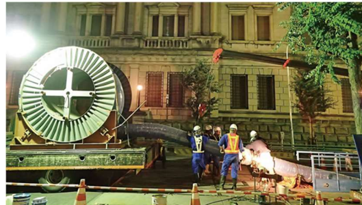
SDF 工法の施工現場
