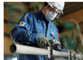
部材の整備工場
