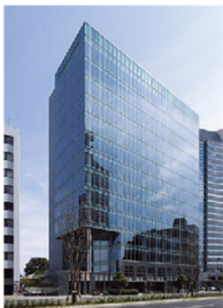
いちご花京院ビル
