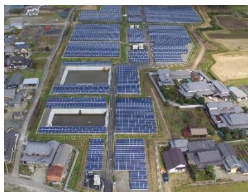
S-18 兵庫多可太陽光発電所 [1,684kW/658百万円]
