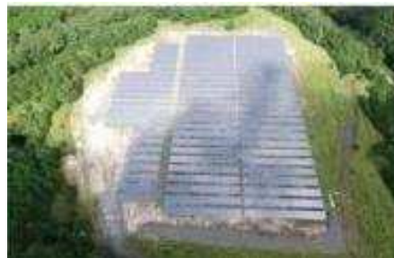
S-02 千代田高原太陽光発電所
