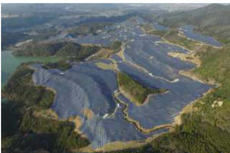
S-07 松阪太陽光発電所
