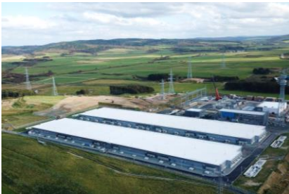
蓄電池システム (容量720MWh) 建設現場 (2020年10月撮影)
