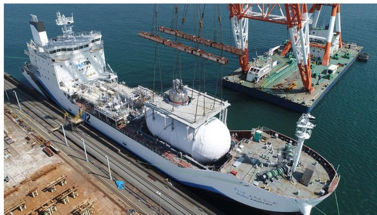
世界初の液化水素運搬船向け「海上輸送用液化水素タンク」搭載工事
