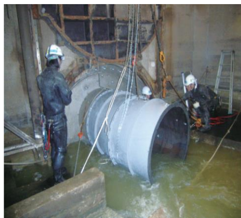
バイパス接続中
