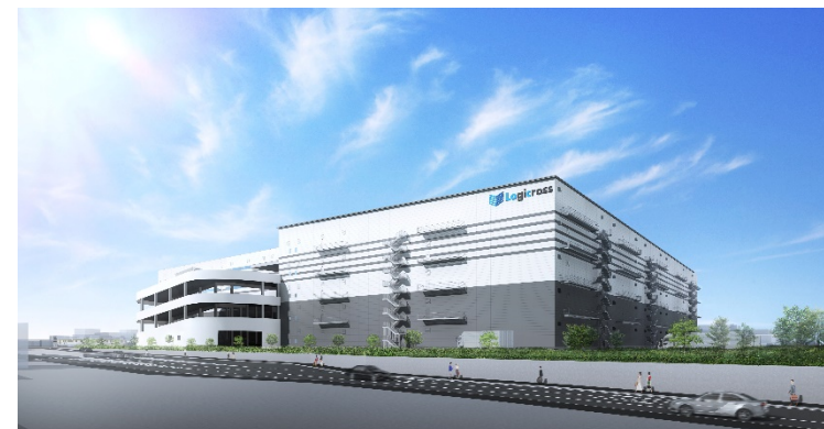
(仮称)相模原市中央区淵野辺プロジェクト
