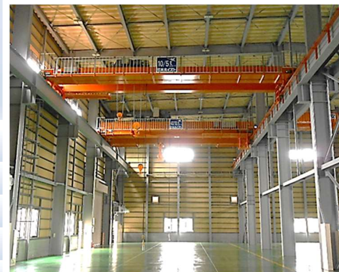
▲ 新潟第4工場の外観(上)・内観(下)
