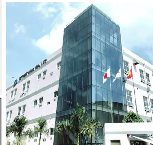
▲ ベトナム第3工場(2020年7月完成)
