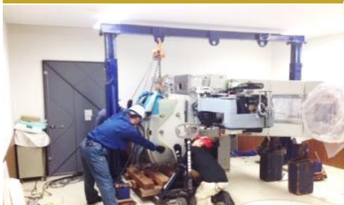
リニアック解体搬出
