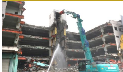
鉄筋コンクリート造解体
