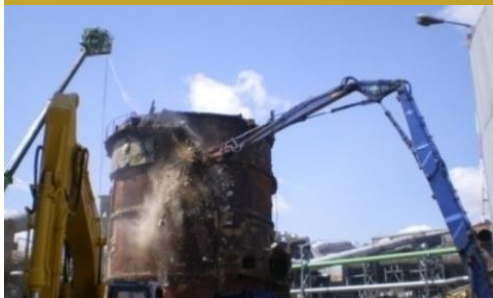
プラント 重機解体
