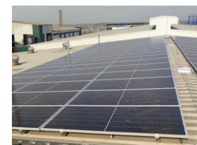
ATG・インド ダヘジ工場
