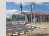
千葉県旭市津波避難ビル誘導サイン
