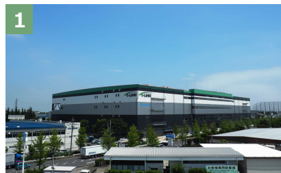
1 T-LOGI久喜 (2020年6月竣工) ⇒満床稼働中。
