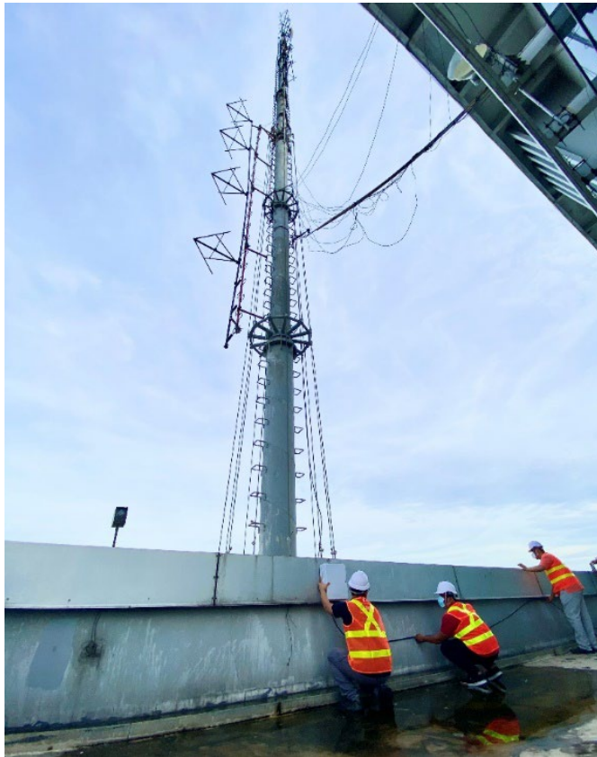
基地局の調査中
