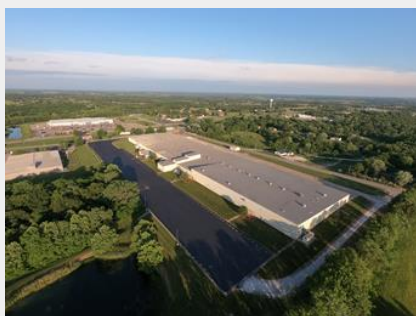
KMMブーンビル工場
