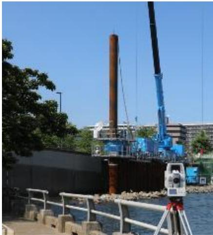
圧入機に連動して杭の貫入深度や変位、傾斜を自動計測
