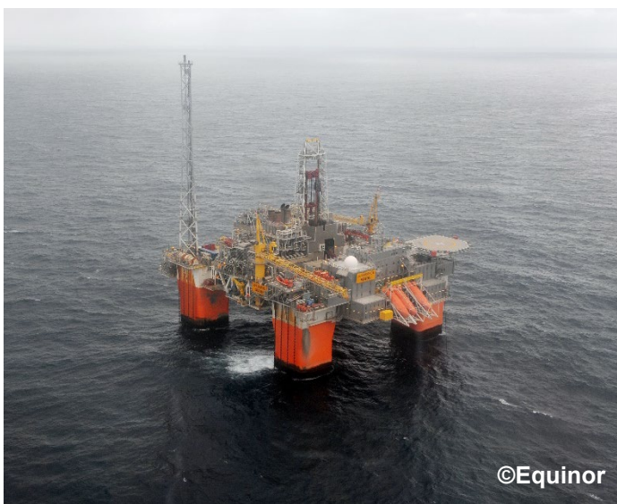
スノープロジェクト生産施設
