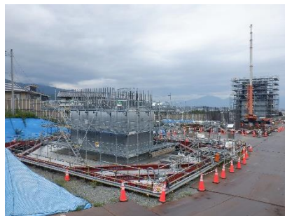
山梨県内高架橋
