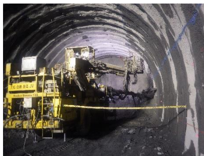
南アルプストンネル (山梨工区)
