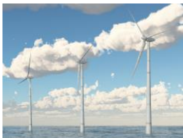
風力発電設備 外観
