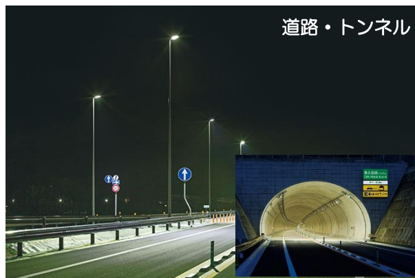
社会インフラを支える照明システム
