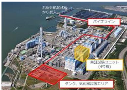
実証事業を行うJERA碧南火力発電所 (愛知県碧南市) 写真提供：JERA
