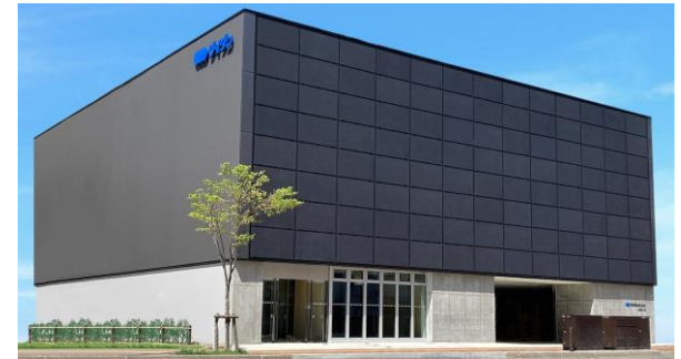
2021年6月竣工 エネフィス北海道
